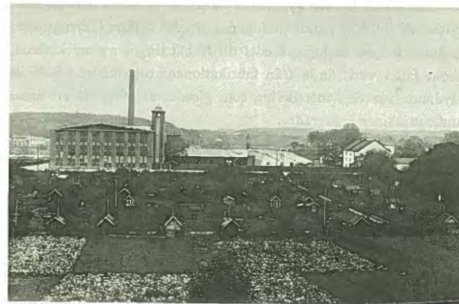
Fabrikskomplexet från väster, med koloniträdgårdar i förgrunden.
