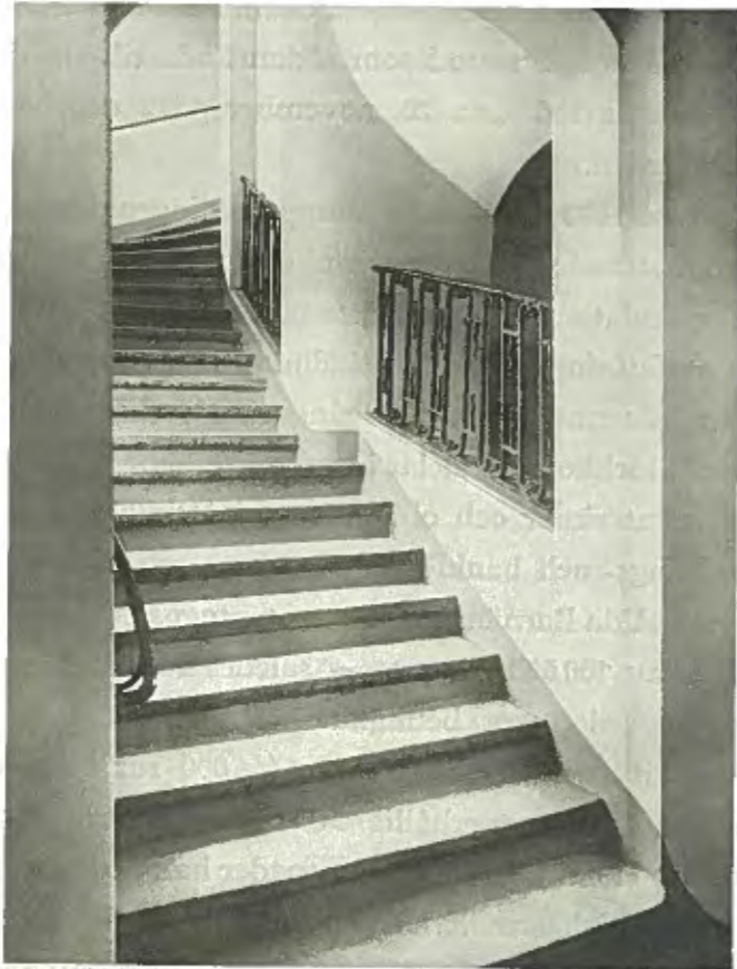
Trappa i Barnängens huvudbyggnad.
