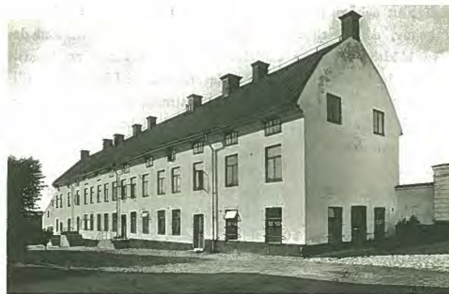
Barnängens äldsta byggnad, i nuvarande skick.
